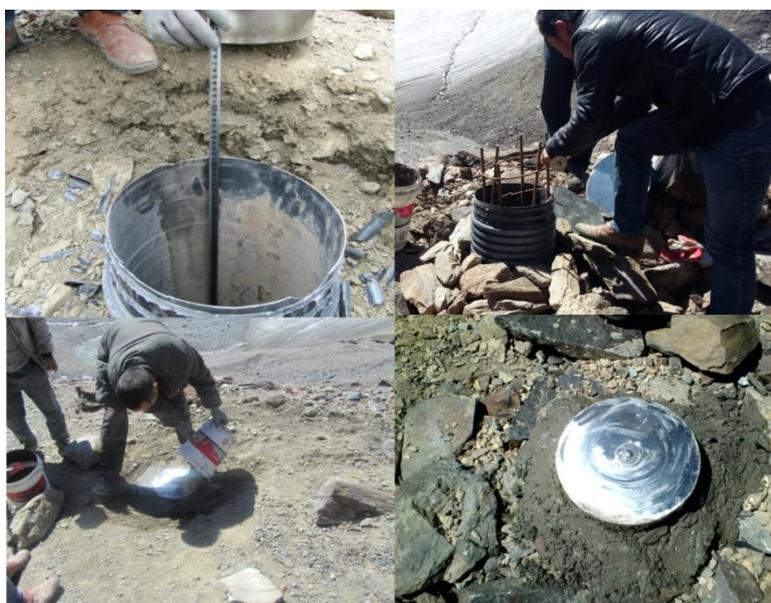
图 3-7 Riegl VZ-6000 仪器基准点布设
