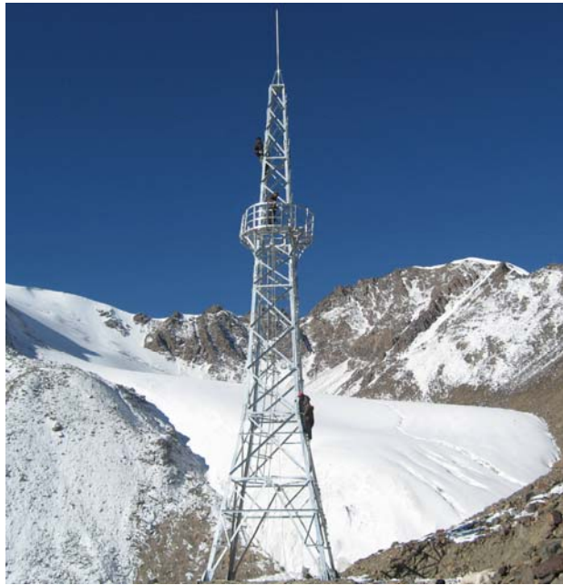
图 1 天山乌鲁木齐河源 1 号冰川监测塔
