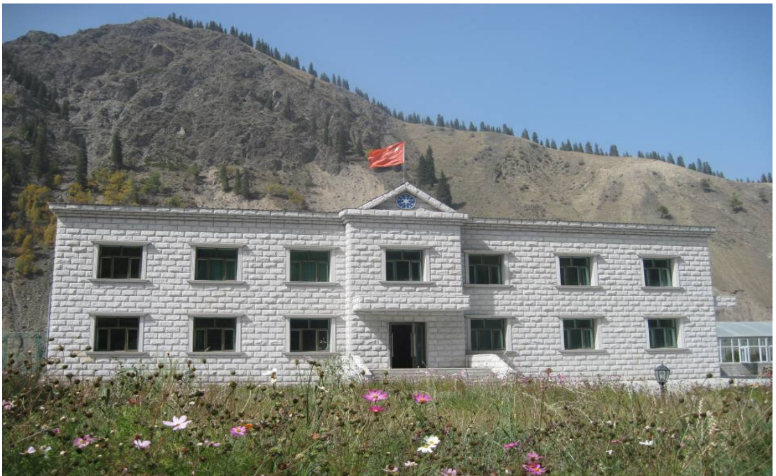
天山冰川站主体建筑—综合楼
