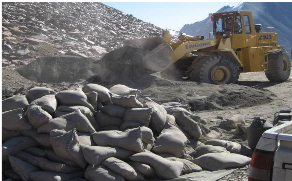
冰川监测塔基座由 60 余吨钢筋水泥浇筑
