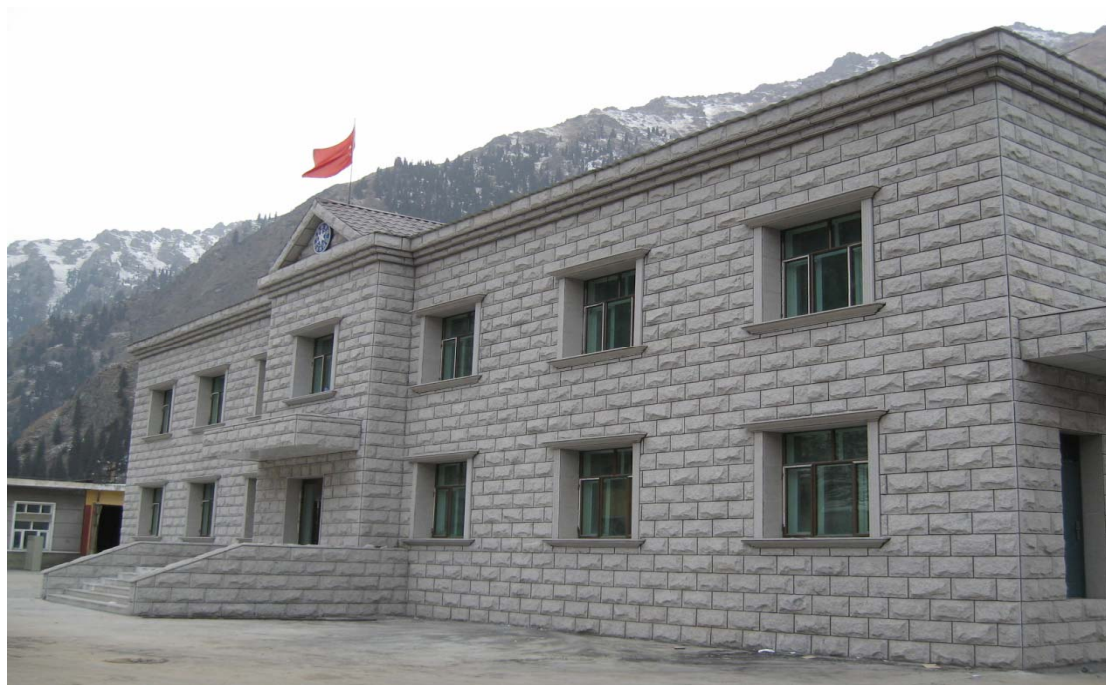
天山冰川站综合楼近景
