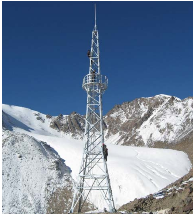
建成我国首个冰川监测塔（11月3日）
